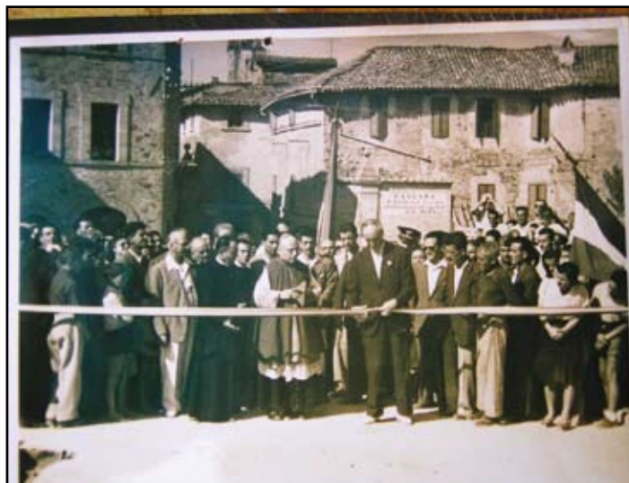
Inaugurazione del Ponte sul Topino, 4 agosto 1946. Fu progettato dall'ing. Salmareggi (Giuseppe?) e realizzato dalla ditta Paci di Vescia di Foligno per conto del Genio Civile di Perugia
